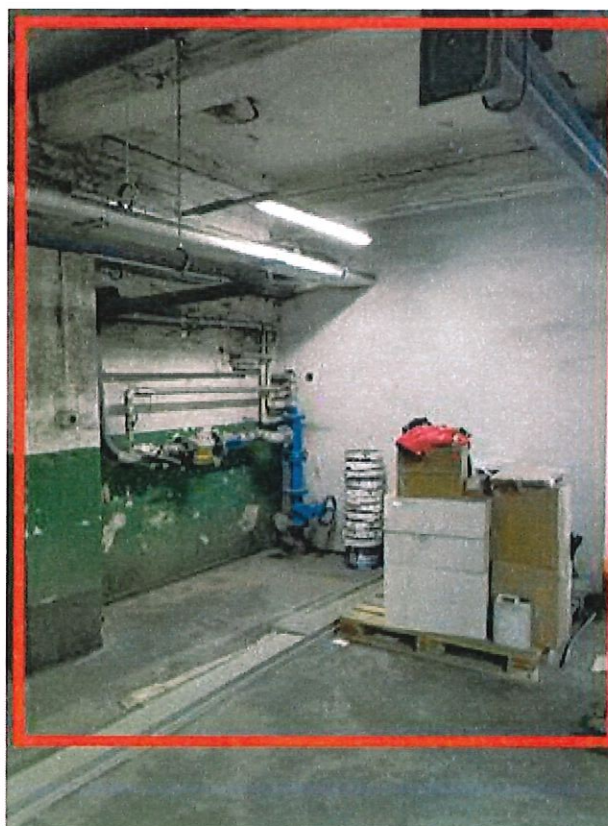
Zdjęcia obecnego pomieszczenia z zaznaczonym obszarem pod wydzielenie nowego pomieszczenia
