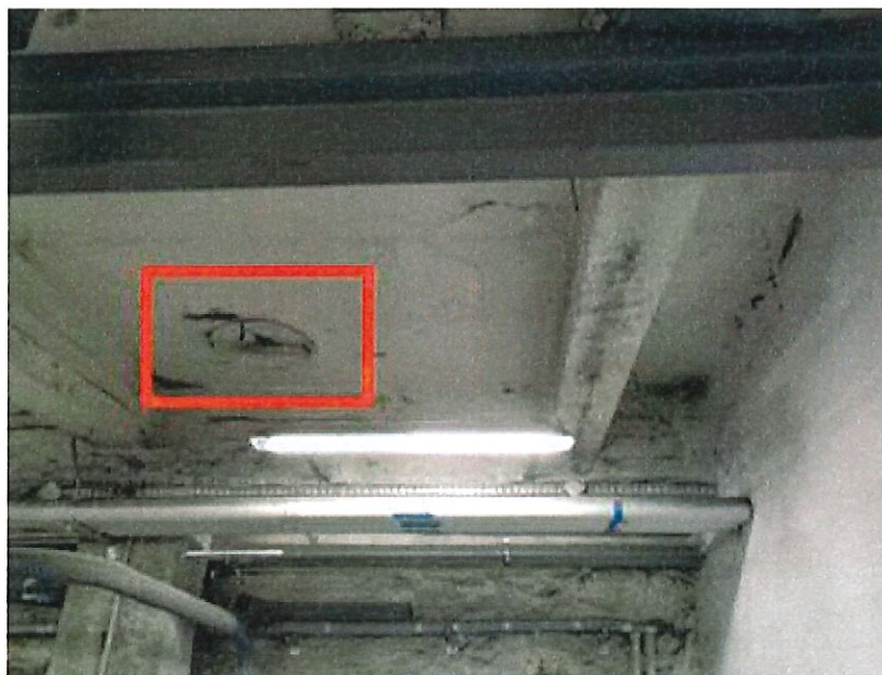
Zdjęcia obrazujące obecny sufit wraz z otworem do całkowitego zaślepienia i uszczelnienia masą uszczelniającą min. EI120
