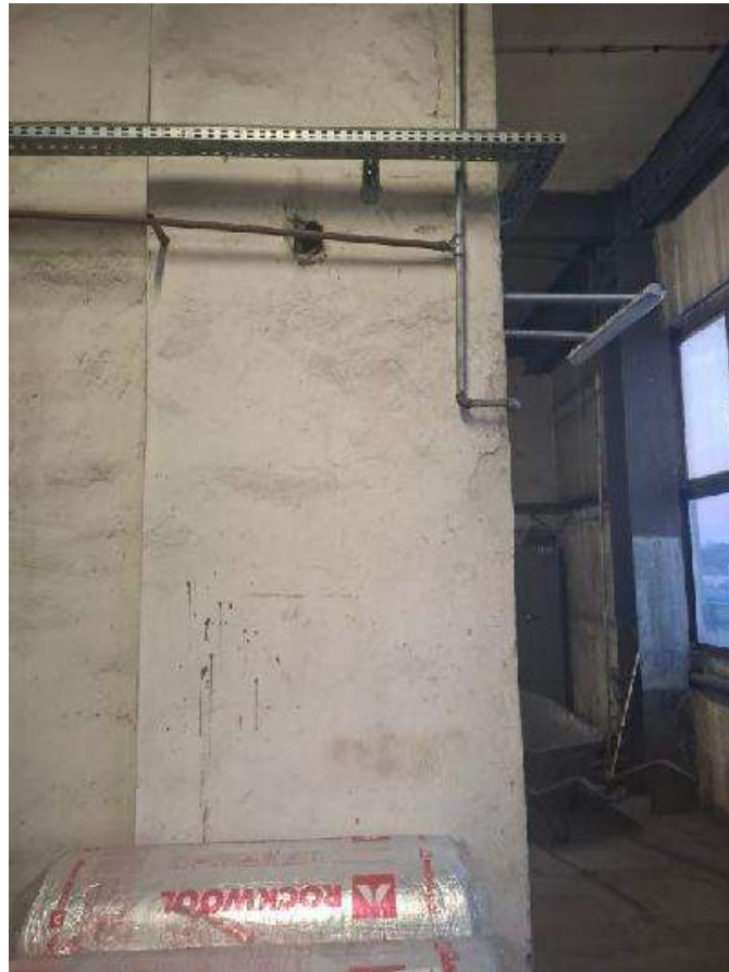
Widok części pomieszczenia
