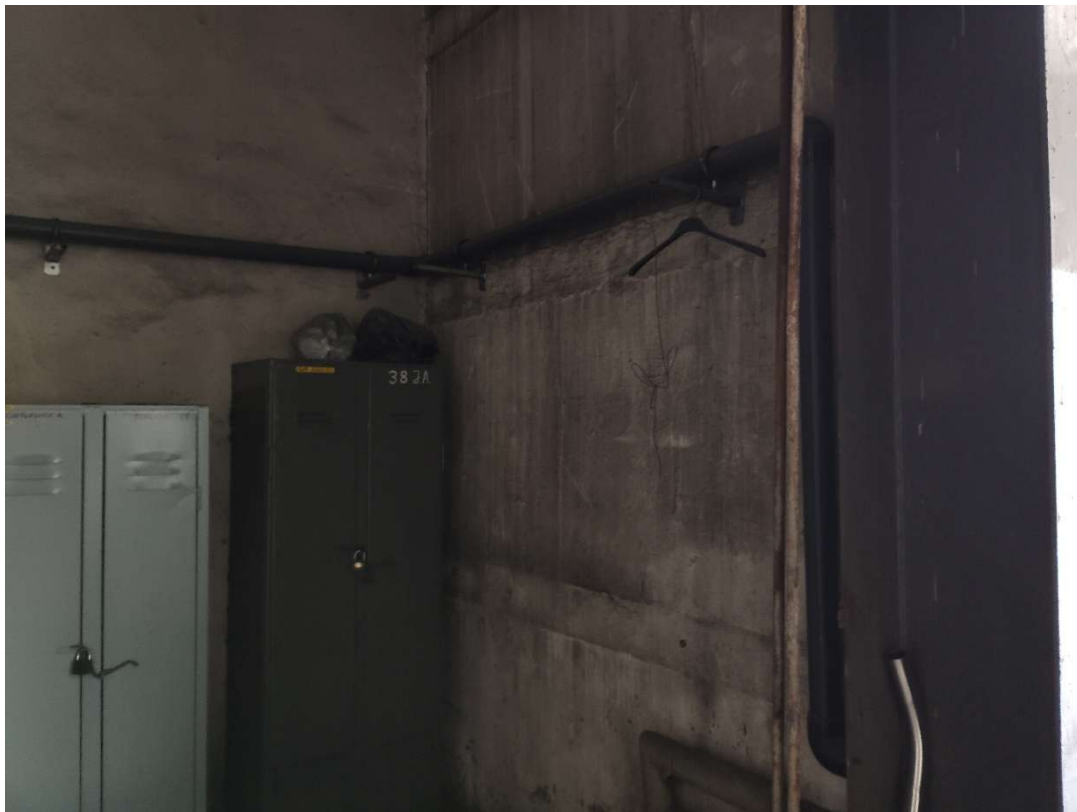
Widok części pomieszczenia
