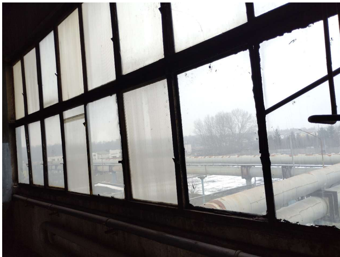
Widok istniejącego przeszklenia
