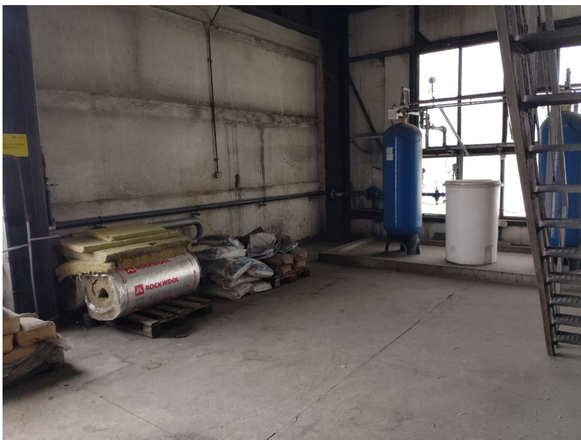
Widok części pomieszczenia
