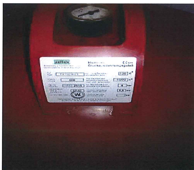
Rys.11. Tabliczka znamionowa stałego zbiornika ciśnieniowego
