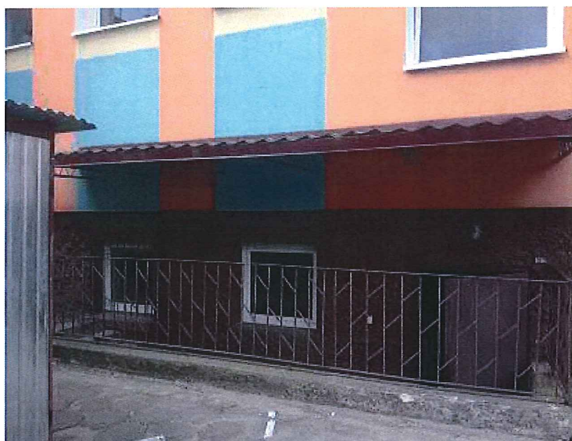
Rys.1. Widok ogólny wejścia do kotłowni od strony parkingu
