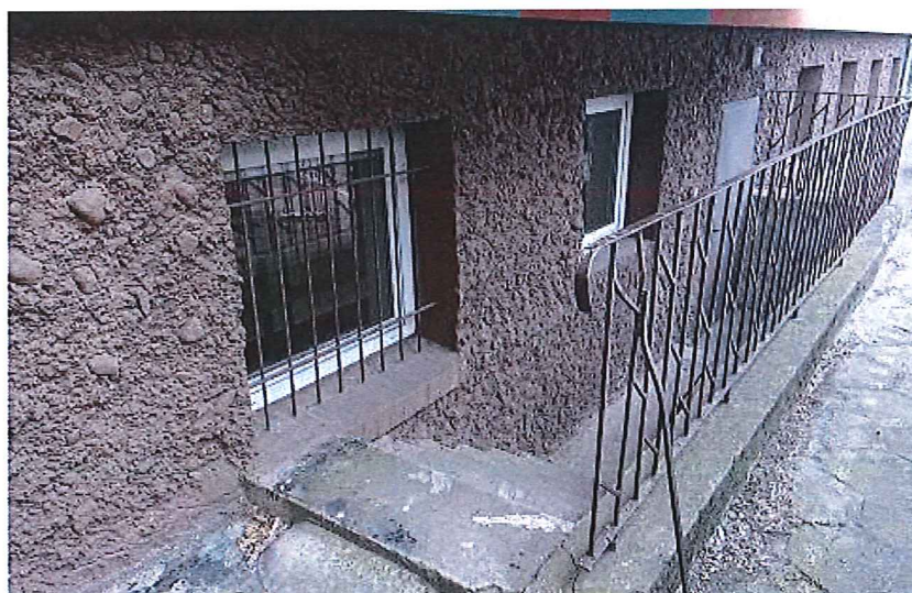
Rys.2. Widok wejścia do kotłowni od strony parkingu
