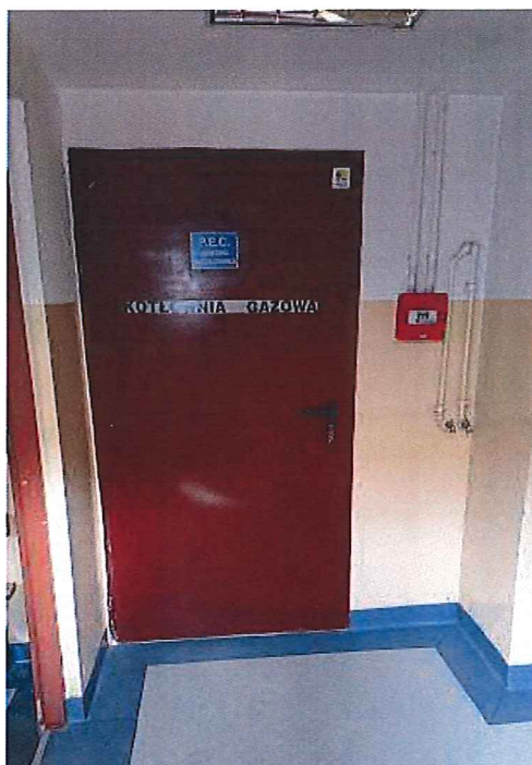
Rys.3. Widok wejścia do pomieszczenia kotłowni od wewnątrz budynku
