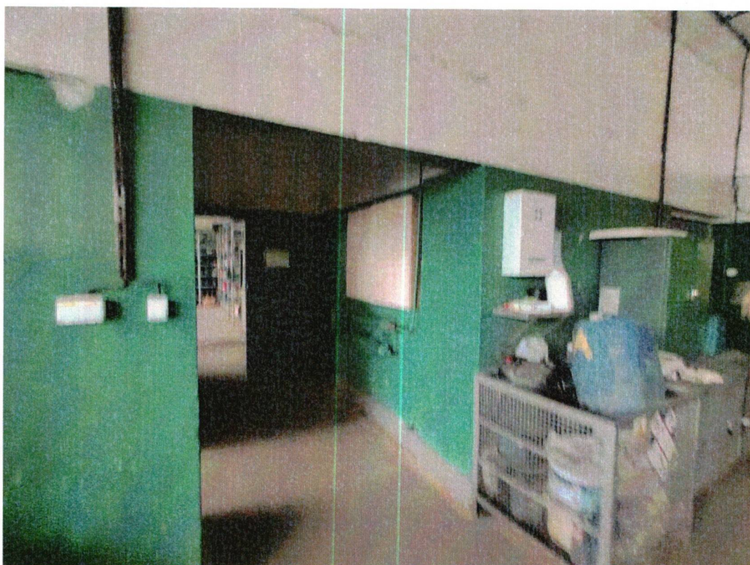
Widok na miejsce przyszłego wejścia do szatni.
