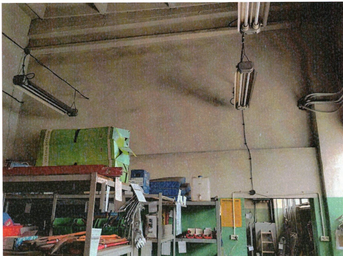
Istniejąca ściana przeznaczona do wyburzenia
