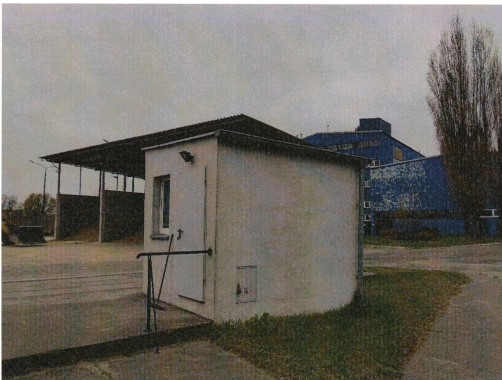
Budynek wagi od strony południowej
