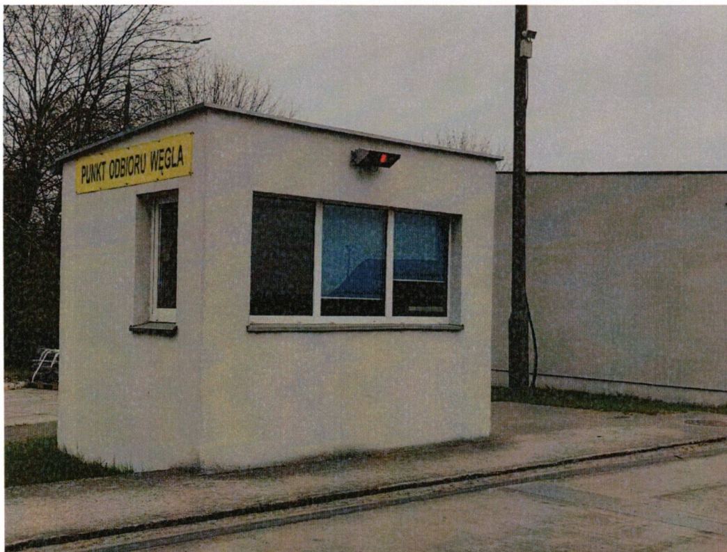
Budynek wagi samochodowej
