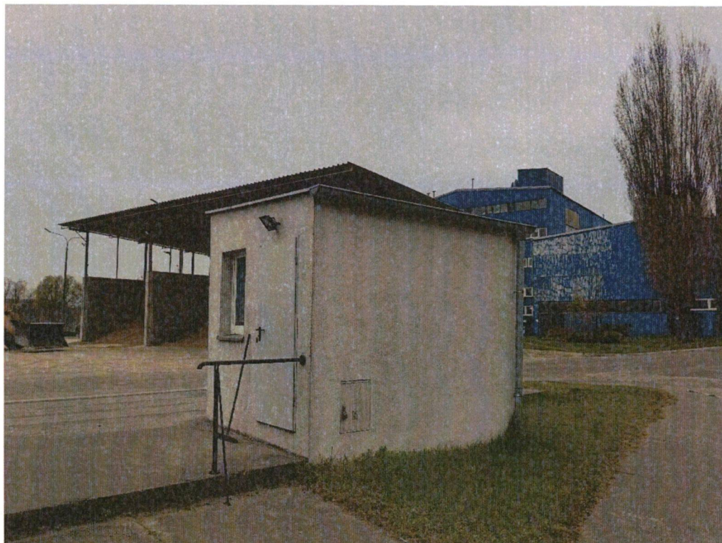
Budynek wagi od strony południowej
