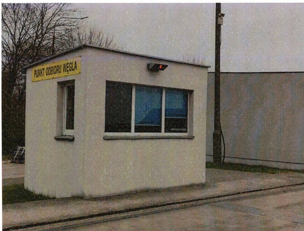
Budynek wagi samochodowej
