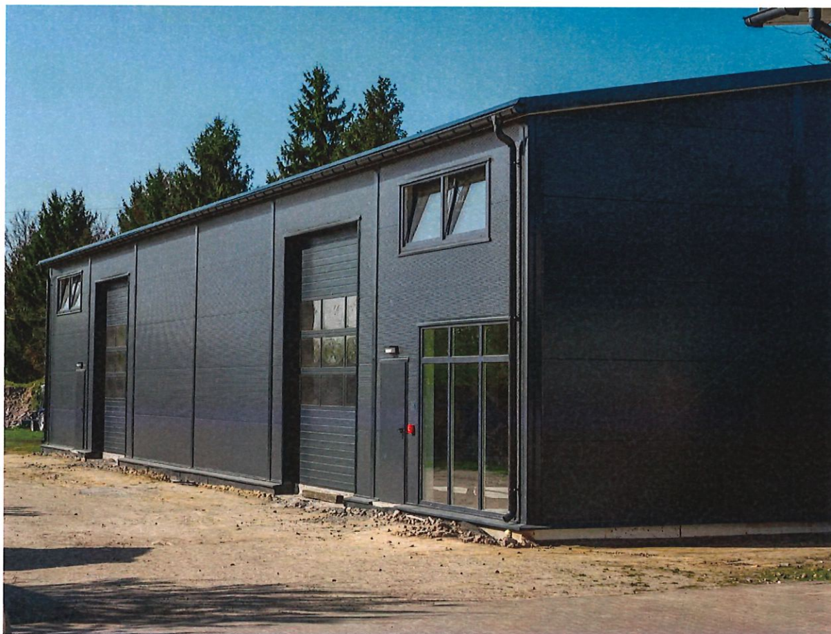
Załącznik nr 6. Poglądowe zdjęcia hali magazynowej.
