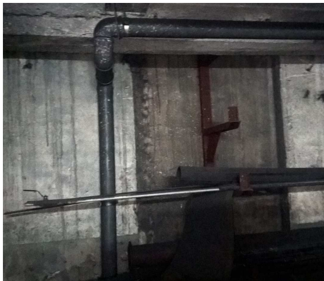
Fot. 4 Ściana wewnętrzna - widoczny przewód do demontażu
