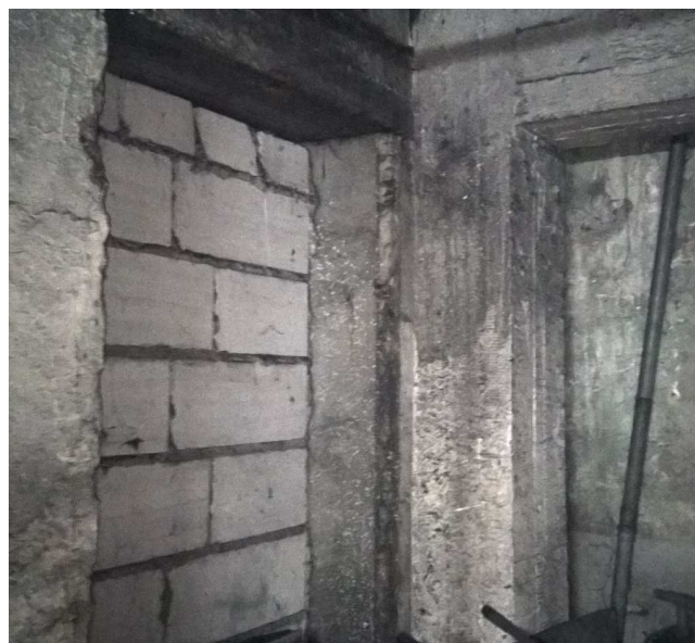
Fot. 2 Ściana działowa murowana-do demontażu Fot. 3 Ściana zewnętrzna - zamurowany otwór do wybicia
