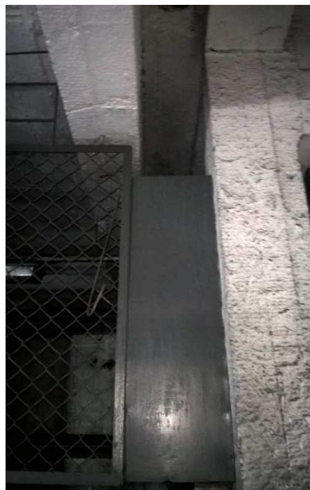
Fot. 1 Ściana działowa - wypełnienie siatką stalową – do demontażu
