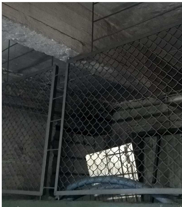
Fot. 1 Ściana działowa - wypełnienie siatką stalową – do demontażu
